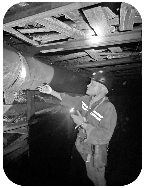
图为康文言在掘进工作面检查风筒漏风情况
