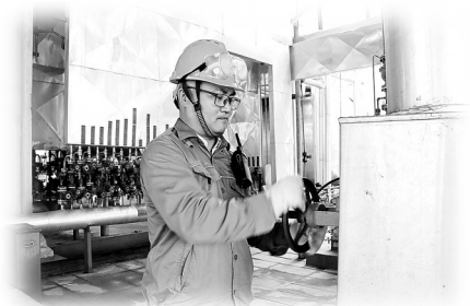
图为黄伟民进行装置现场巡视检查工作
