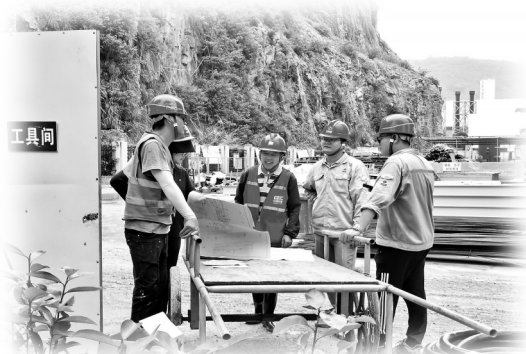
图为苏鑫洪(右三)组织验收人员现场讨论施工问题
