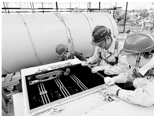
▲ 12月5日,鸿山热电公司#1启备变检修正式拉开帷幕。启备变是保证安全生产的重要备用电源,该公司设备维护部党支部成立电热专业党员突击队,高效率完成检修工作。
