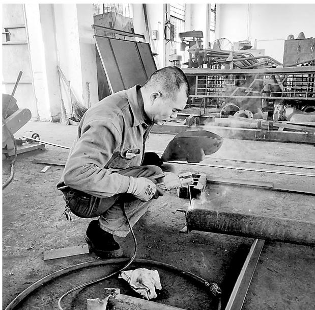
▲ 近日,福建煤电公司龙潭煤矿井下新安装一条猴车道,该矿机电队严格按照设计要求自行加工制作猴车机头防护栏。图为12月3日,机电队电焊师傅在焊接防护栏固定组件。
