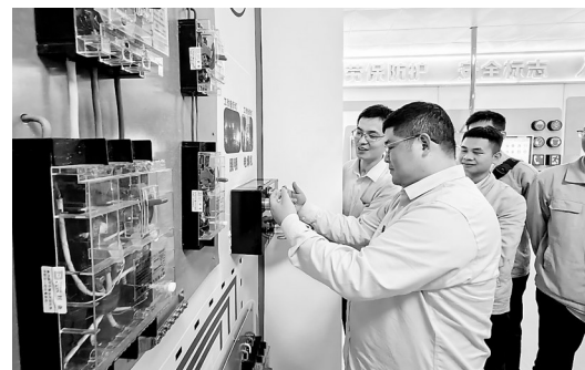
11月13日，石狮热电公司组织一线员工前往鸿山热电公司，开展安全与消防现场VR学习互动体验。（方启娟 摄）
