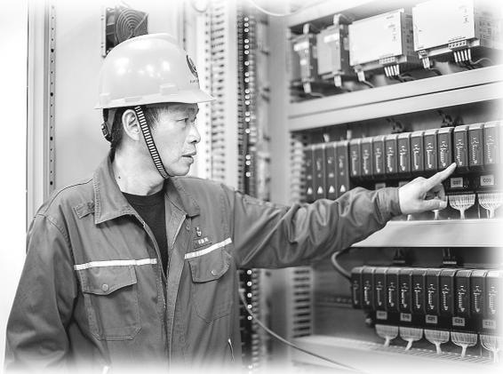
图为蔡鑫英在检查DCS控制柜卡件运行状态
