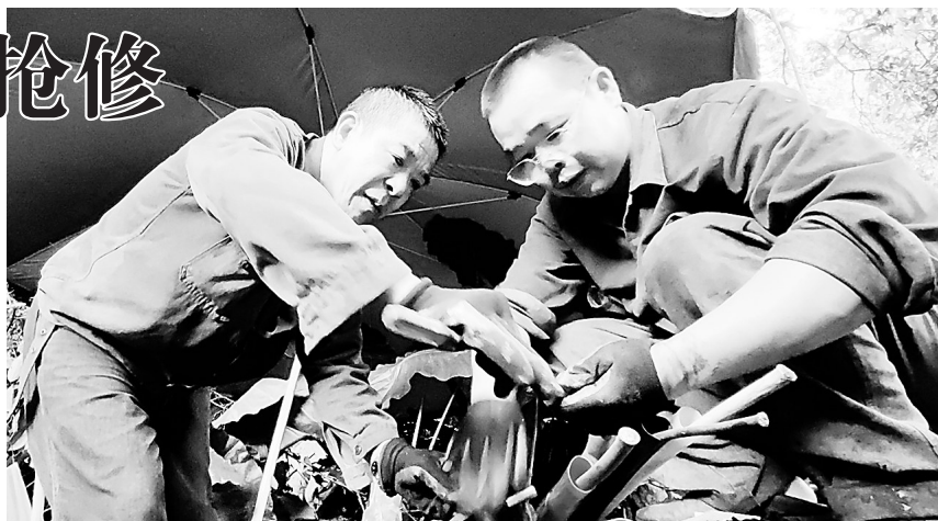
图为机电人员抢修现场
