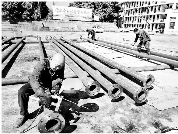
图为生活区老化供水管网改造施工现场
