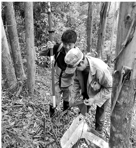
近日,为加速推进项目用地前期筹备工作,东田抽蓄公司认真开展项目建设征地红线临时界桩的测设工作。图为测量人员与当地村民向导在布设临时界桩。(黄思跃 摄)
