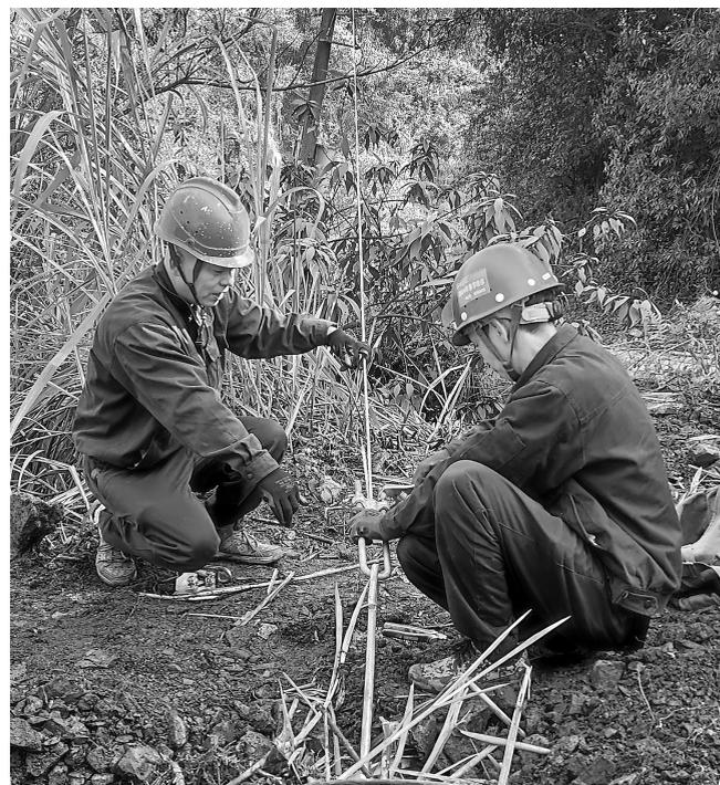
▲ 福建煤电电力安装检修公司积极组织开展春季供电线路通道特巡工作，扎实做好电网安全保供。图为3月12日，巡线组在发现田螺形民爆物品储存库的线杆存在倒杆险情后，迅速组织抢修。(张建文 摄)
