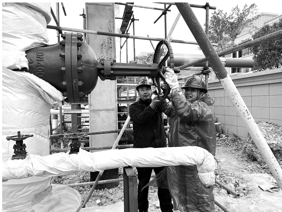
近日,鸿山热电公司海洋科技园延伸建设工程(加多宝支线)主管道稳压吹扫工作圆满完成。海洋科技园延伸主管道总长共3000米,顺利投运后将供热管道延伸至祥芝东北部工业区域,为公司供热市场的拓展和市场的多元化奠定良好基础。(蔡雄勃 摄)
