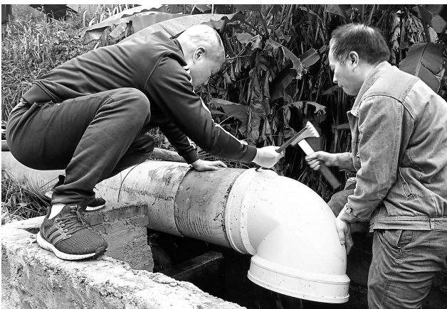
近日,福建煤电公司箭竹坪煤矿组织相关人员对地面的防洪、排水设施进行专项排查治理行动。图为该矿人员对照整改清单上的内容更换导水弯头。(李锦华 简盛敏 摄)
