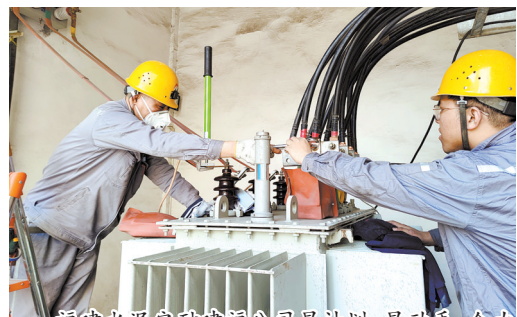
福建水泥安砂建福公司早计划、早动手，全力备战节后生产。图为2月19日，检修人员对包装变压器进行保养、维修。(黄新伟 摄)
