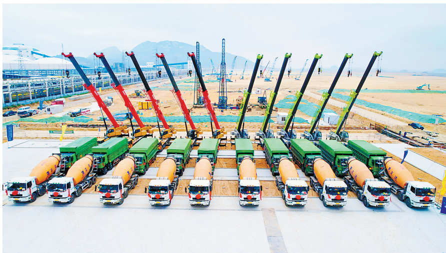
图为中沙古雷乙烯项目主体工程开工现场。(陈汉祥 摄)
