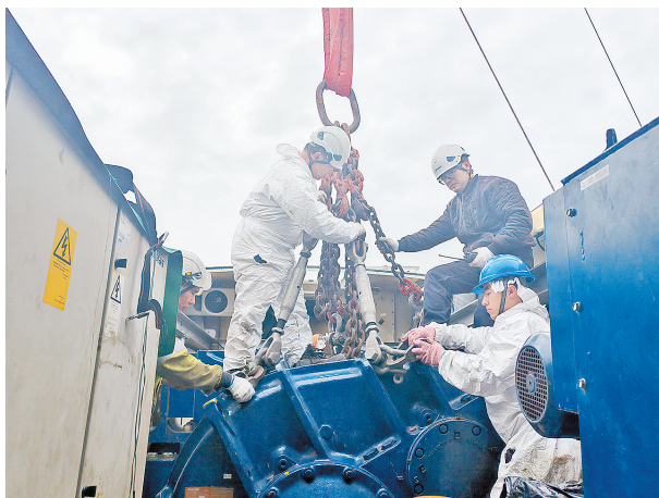
▲ 2月5日，福能新能源公司后海风电场克服困难，精准把握小风窗口期，抢在节前顺利完成#36风机齿轮箱更换工作，为春节前计划性检修工作上圆满句号。(潘建仙 林右文 摄)
